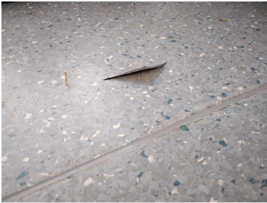
Taukotilassa muovimaton alustassa ei vaurioita havaittavissa
